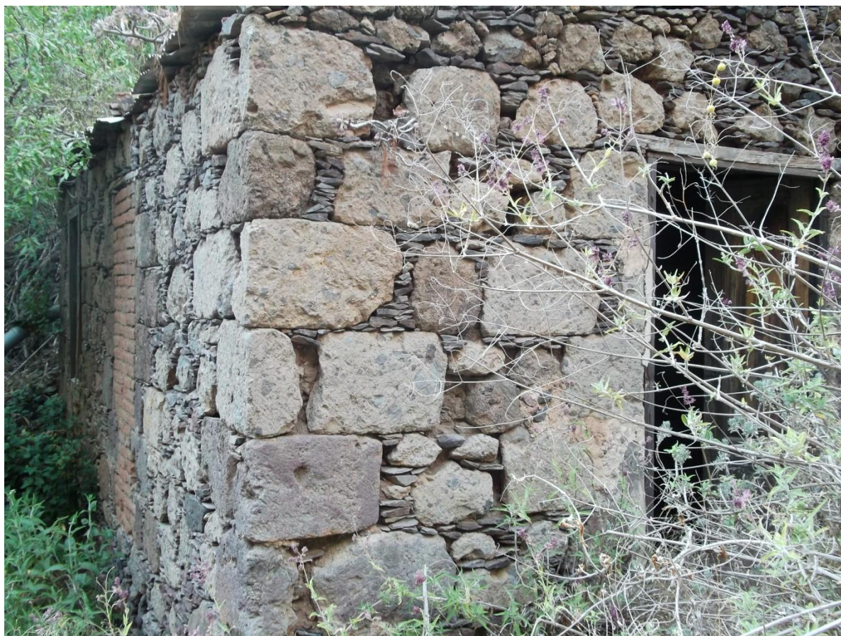
Detalle de un antiguo molino de agua en la zona de El Sao. Para la fabricación de los muros de mampostería se usaron materiales locales, correspondiéndose a brecha y tobas del ciclo Roque Nublo, junto con lajas y cantos fonolíticos y basálticos del Ciclo I. Foto: Juan Francisco Betancor.
