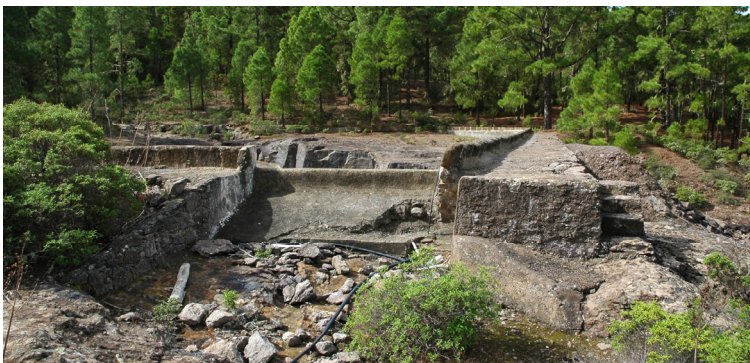
Detalle del aliviadero de la Presa de los Rajones (Foto Jaime González)
