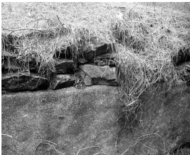
Detalle del enlucido y borde exterior de piedra “estanques de los nacientes” (Foto Jaime González)
