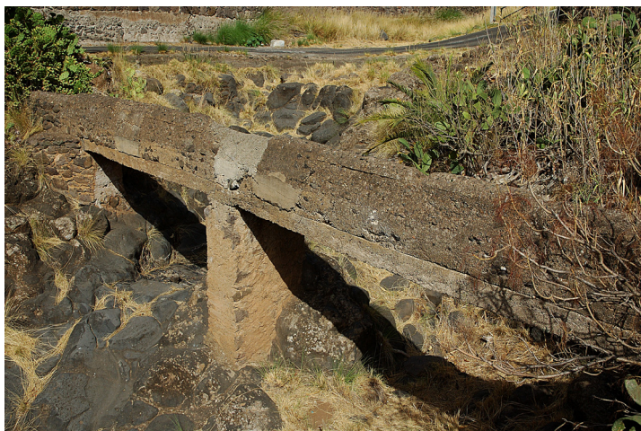
La Tubería Samsó a su paso por el Valle de Agaete
