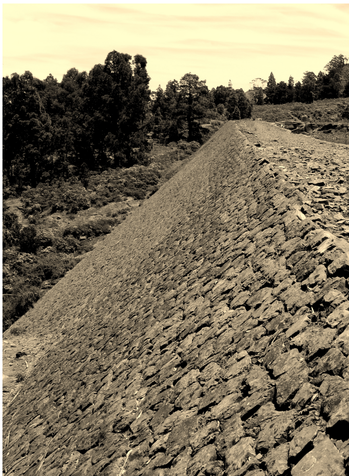
Paramento de aguas abajo de la Presa de Tamadaba (Foto Jaime González)
