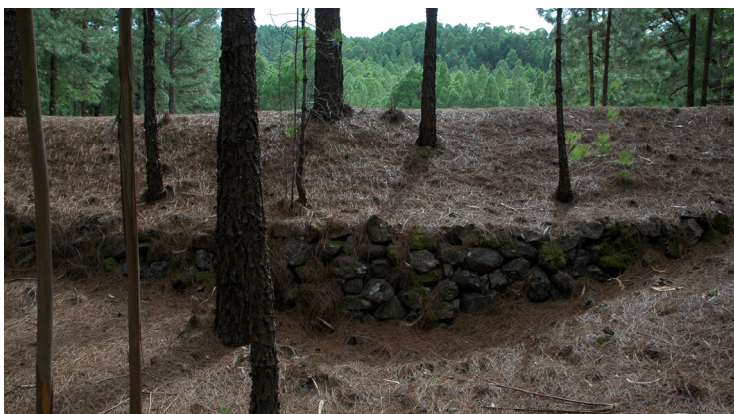
Detalles del muro de La Laguna (Fotos Jaime González)
