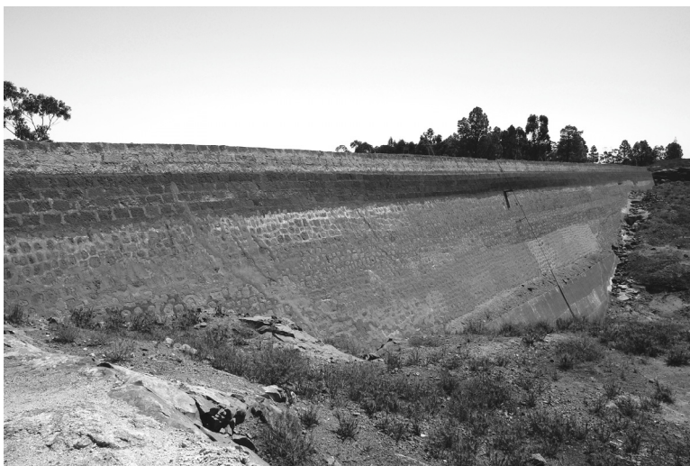
Presa de Tamadaba (Fotos Jaime González)
