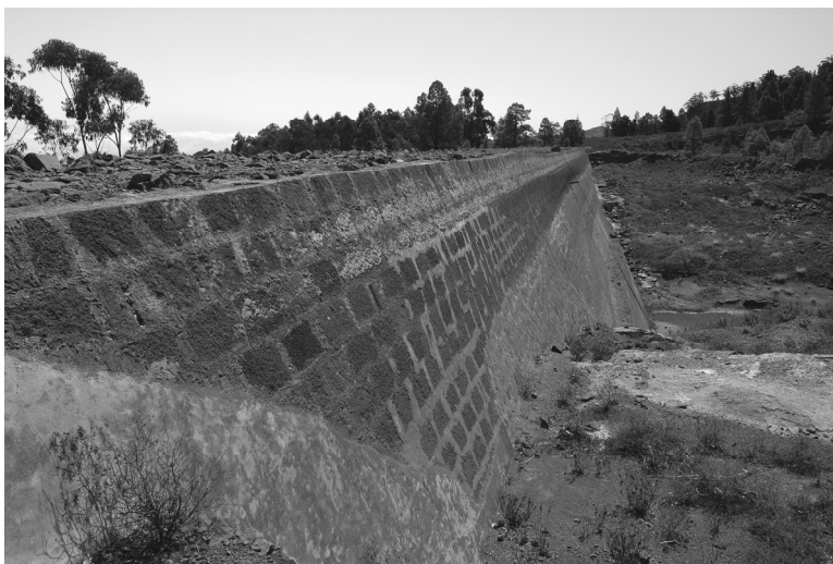
Presa de Tamadaba (Fotos Jaime González)
