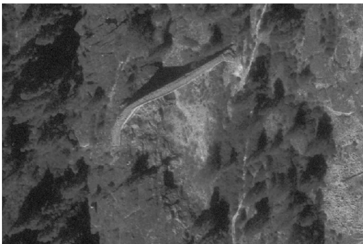
Presa de las Lajas (Foto aérea de Enero de 1987 – GRAFCAN)
