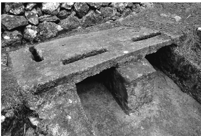
Detalles de uno de los aliviaderos del Canal de Tamadaba (Fotos Jaime González)
