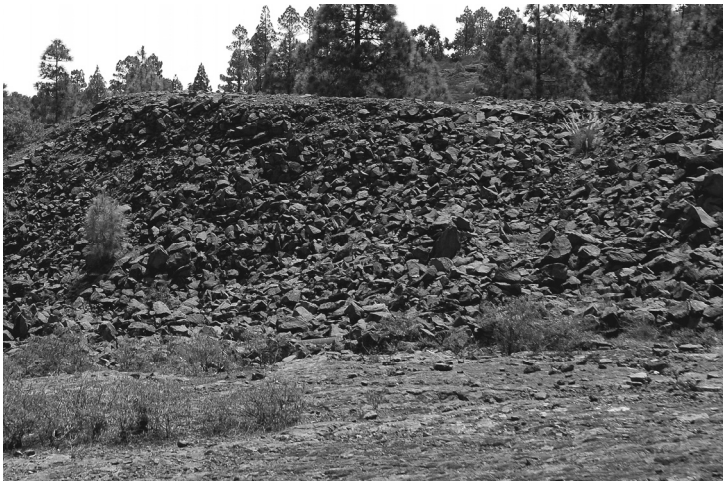
Estos escombros son la mampostería seca de la Presa número 2
