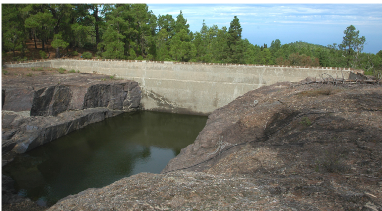
Paramento aguas arriba de la Presa de los Rajones (Foto Jaime González)
