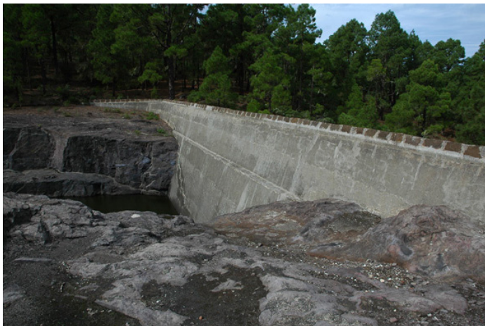
Presa de Los Rajones (Fotos Jaime González)
