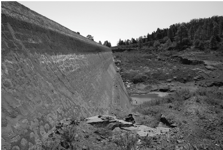
Obra y Terreno (Foto Jaime González)
