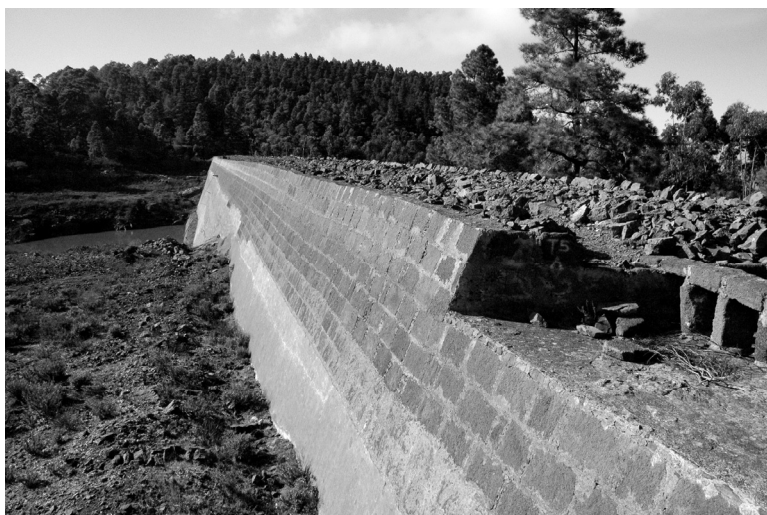
Presa de Tamadaba (Fotos Jaime González)
