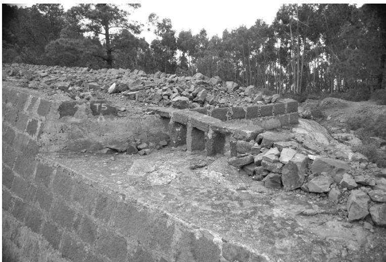
Detalle del aliviadero de la Presa de Tamadaba
