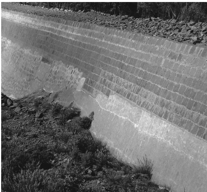
Detalle del enlucido con mortero bastardo de cal y cemento (Foto Jaime González)
