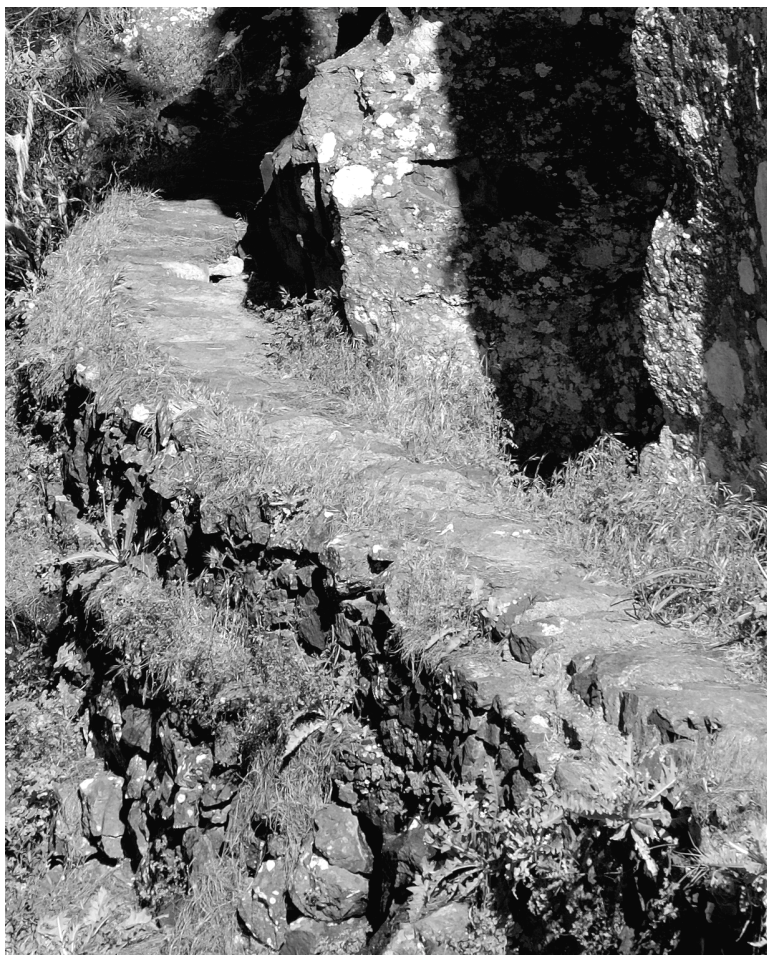
Parte del trazado del Canal de Tamadaba que fue cubierto con losas de piedra toscas del lugar , tal y como recogía el Proyecto de Canal de Tamadaba de 1942 (Foto Jaime González)
