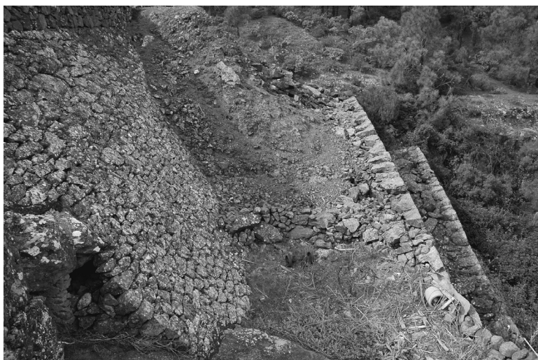
Detalles de la Presa de los Rajones (Fotos Jaime González)
