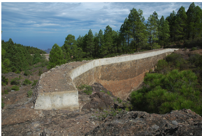
Presa de las Lajas (Fotos Jaime González)
