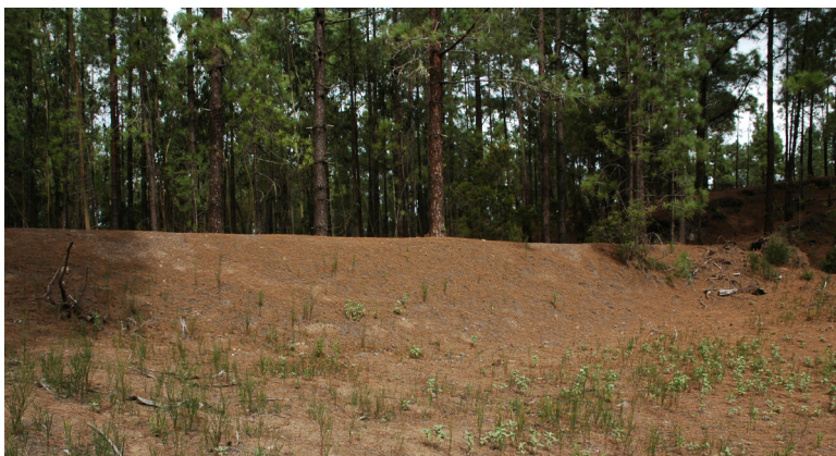
El muro de La Laguna desde aguas arriba
