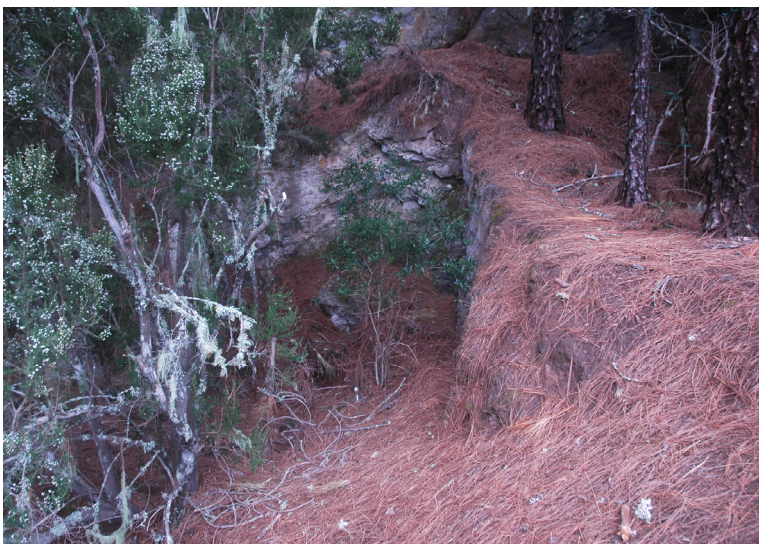
Detalle de la zanja de cimientos (Barranco de las Lajas) Otro yacimiento hidráulico de “interés” (Foto Jaime González)
