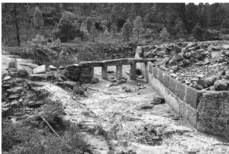
Detalle del aliviadero desde el canal de descarga
