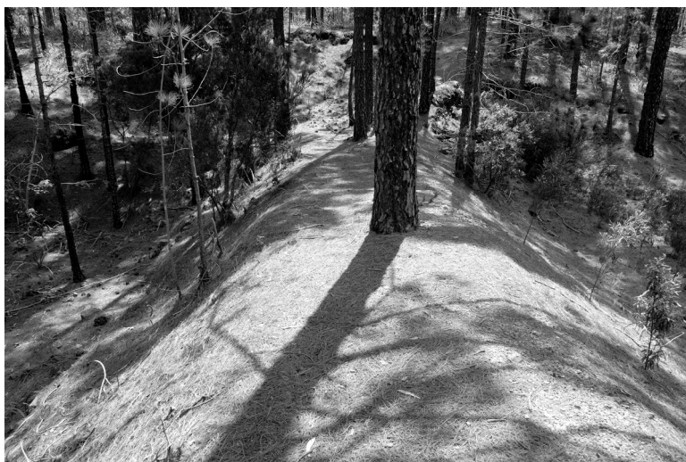
Detalle del muro de La Laguna desde su coronación
