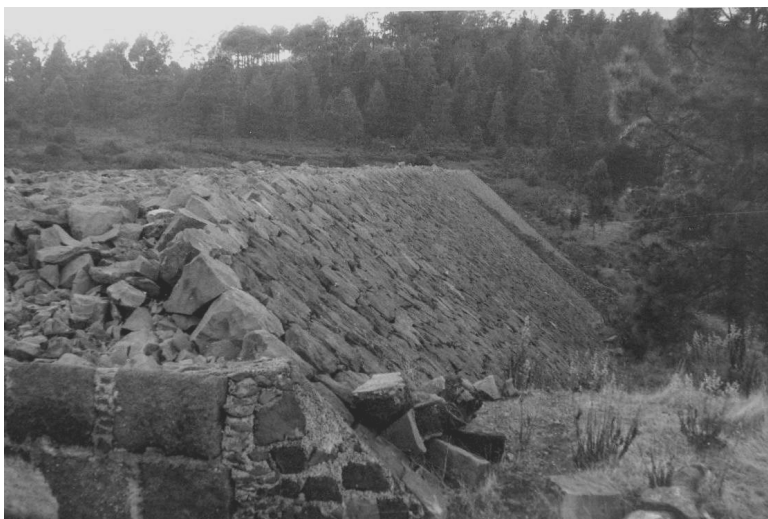
Detalle de la Presa de Tamadaba (1971) (Fotos Inventario de presas del SPA-15, CIAGC)
