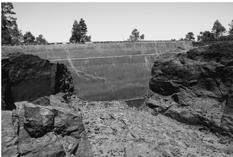
Paramento aguas arriba de la Presa de los Rajones (Fotos Jaime González)
