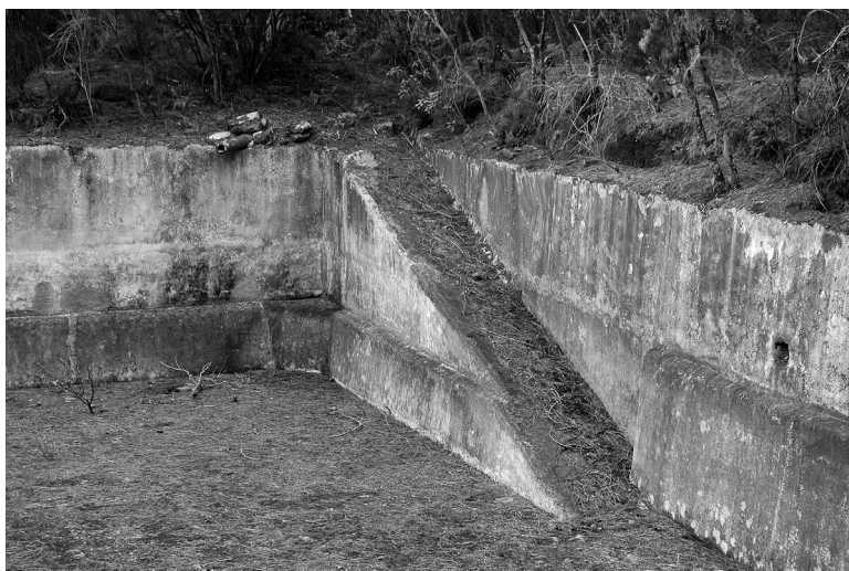
Detalle de la rampa de acceso al Estanque superior de la Huerta
