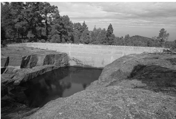
Presa de los Rajones (Fotos Jaime González)
