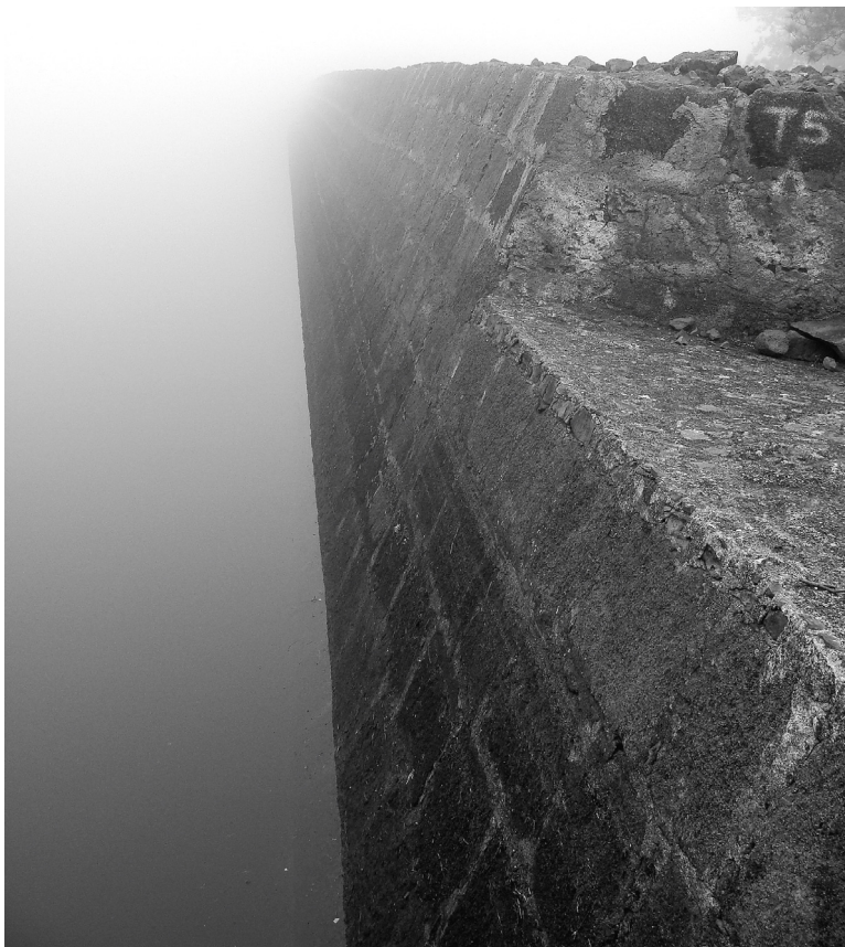
Detalle de la Presa de Tamadaba con embalse casi lleno
