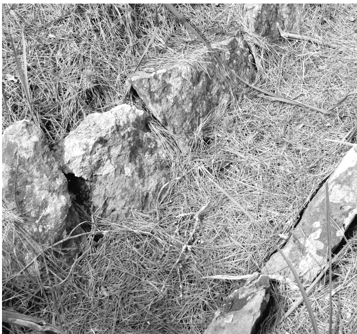
Canal Barranco de Saavedra a Presa de los Rajones (detalle)
