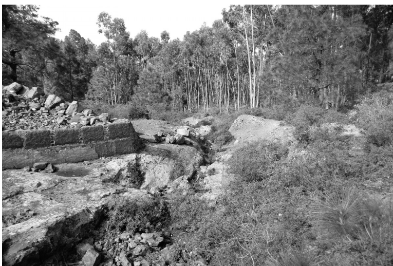
Inicio canal de descarga del aliviadero de la presa
