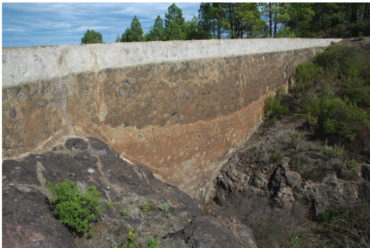
Presa de las Lajas (Barranquillo de las Presas) (Fotos Jaime González)
